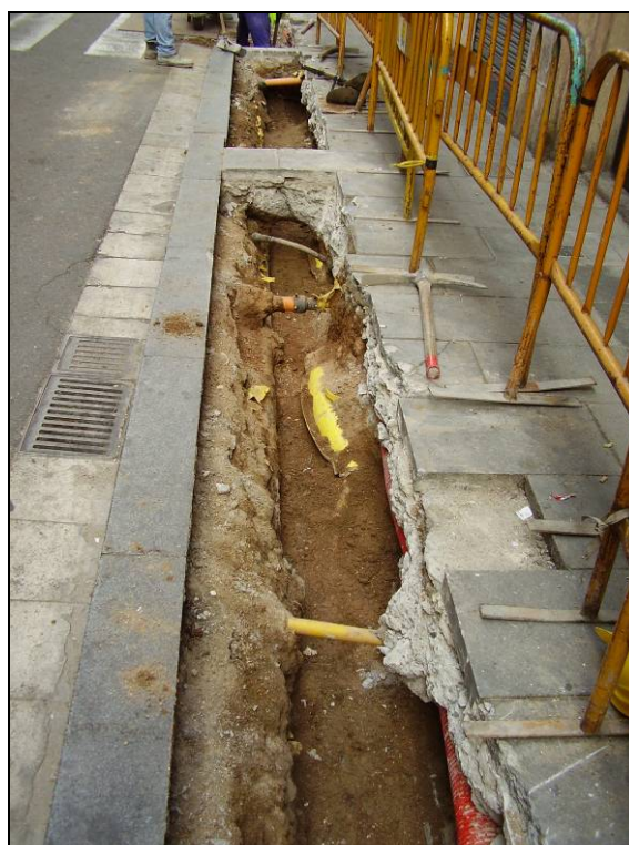
Foto núm.10 Rasa 200, estat final
