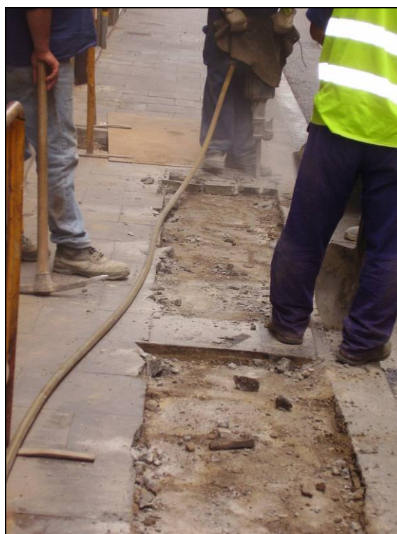
Foto núm.2 Inici dels rebaixos del paviment a la Rasa 100
