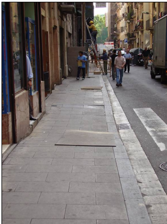
Foto núm.7 Rasa 200, carrer Nou de la Rambla abans de l'inici dels treballs
