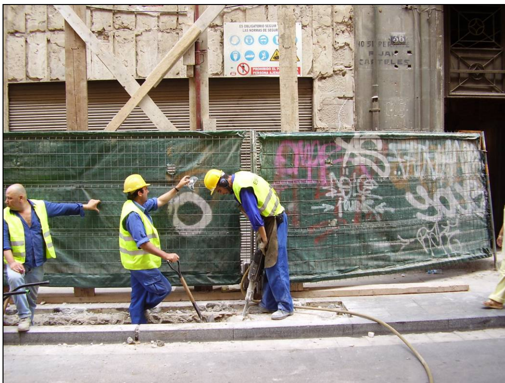
Foto núm.8 Rasa 200, treballs d'aixecament del paviment UE201
