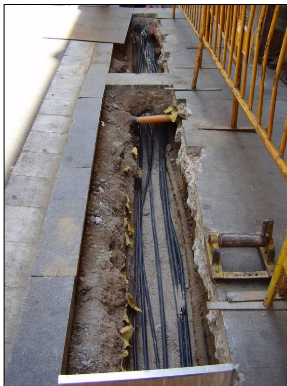
Foto núm.12 Rasa 200, col·locació del cablejat elèctric.
