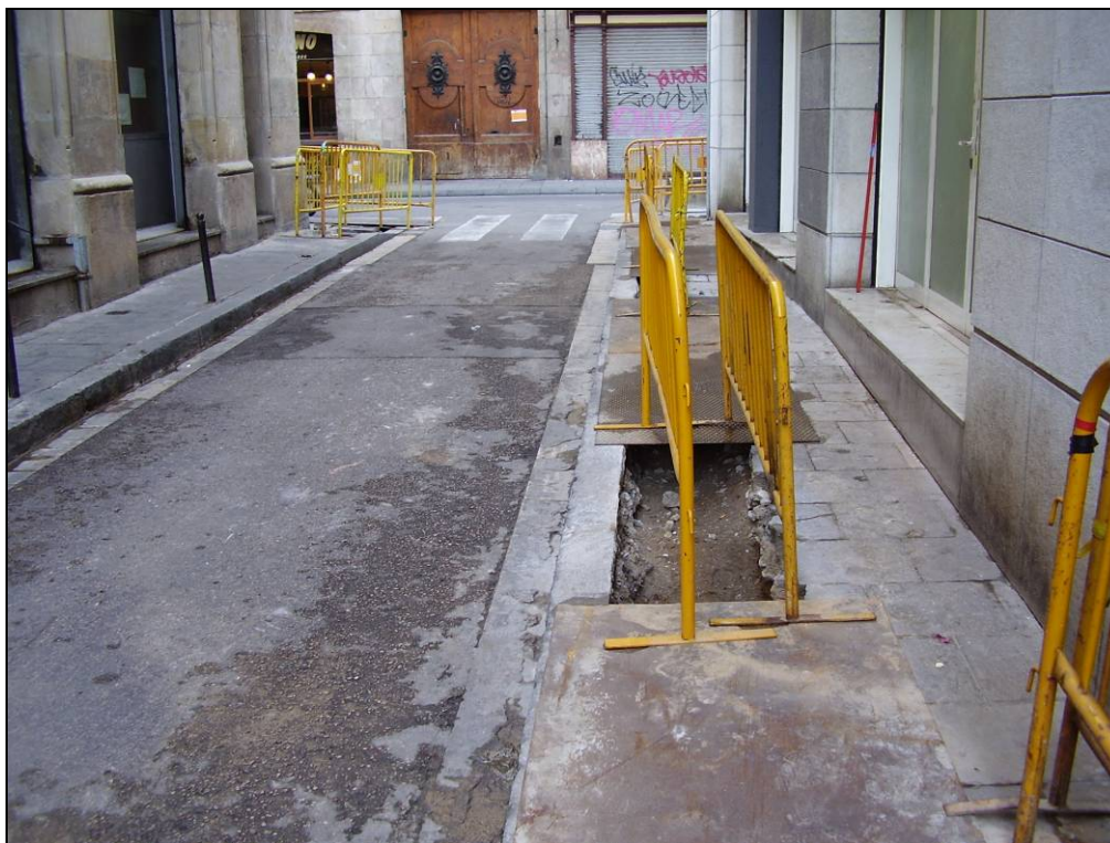
Foto núm.1 Carrer de l'Est. Vista general de la Rasa 100
