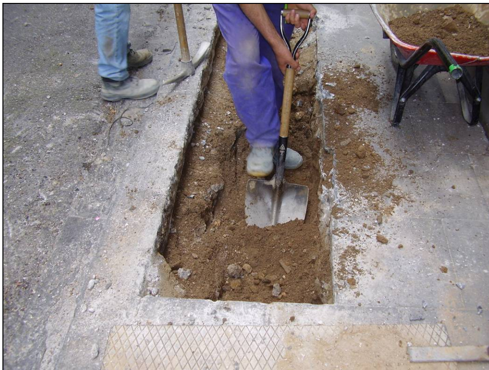
Foto núm.3 Rebaixos del sediment UE102 de la Rasa 100
