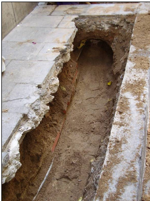
Foto núm.5 Rasa 100, estat final
